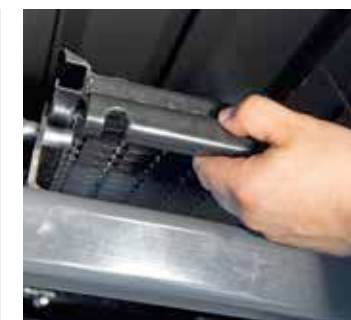
Демонтаж на ситата
